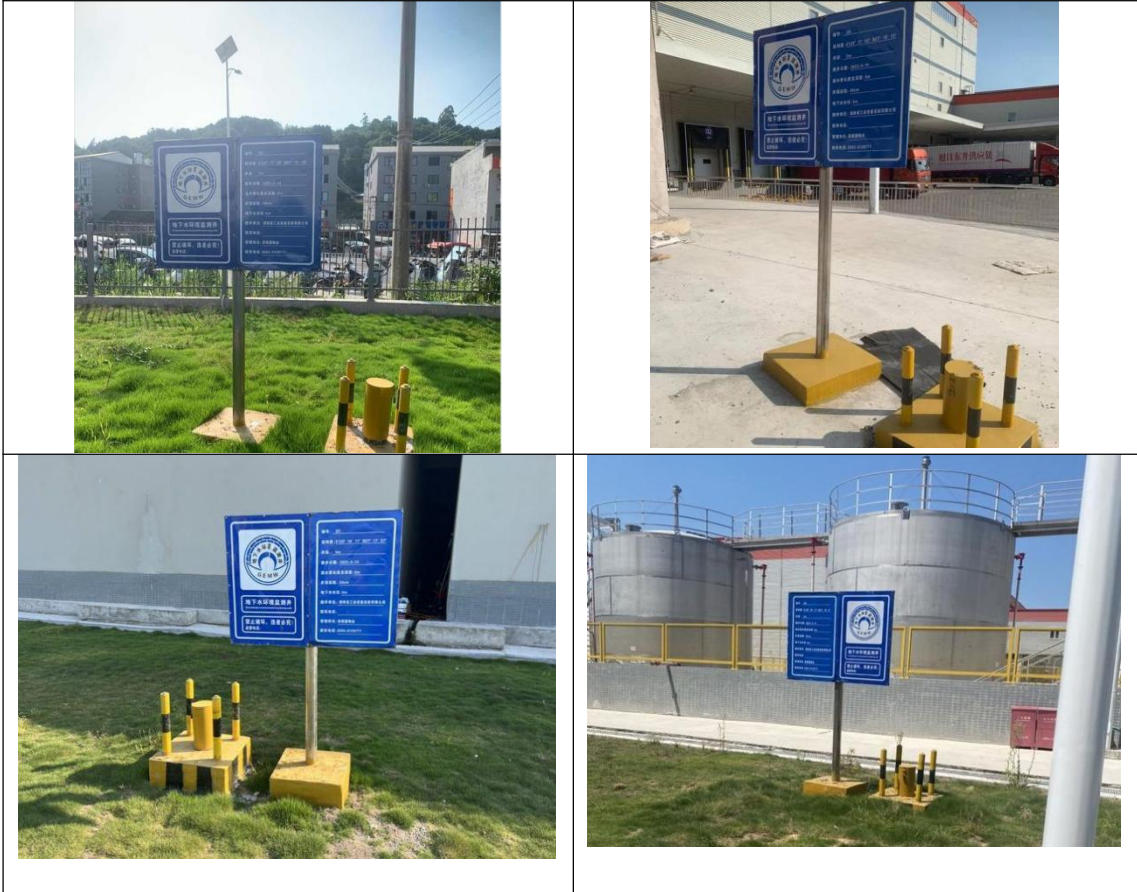
地下水监测井
