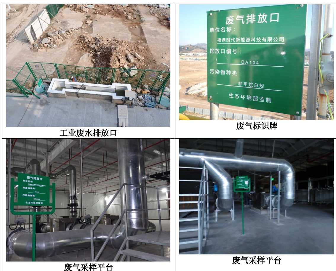
图 4.2-1 废气标识牌、采样平台图
