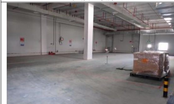
FD3 危废仓防渗、分期存放
