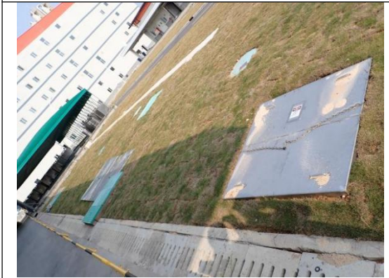
FD4 电解液仓外事故池
